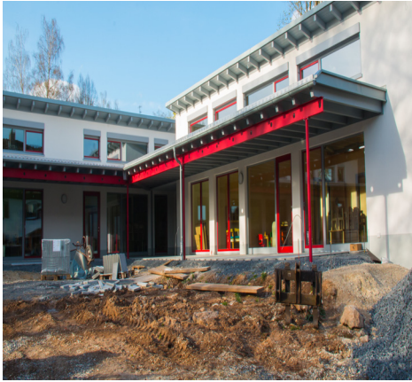
Nicht mehr lange sieht es hier nach Baustelle aus
