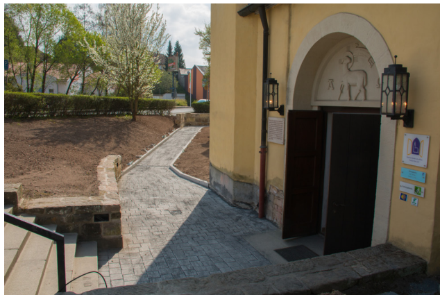
Zugangsbereich zum Kicheneingang
